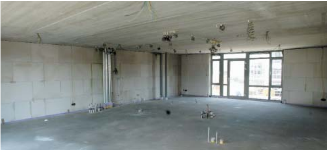
Grote vrije ruimte, zonder hinderlijke dragende tussensteunpunten, geeft maximale flexibiliteit betreffende indeelbaarheid
