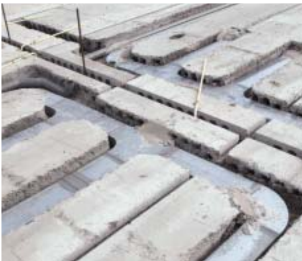
Gebalanceerde ventilatiekokers in vloerveld
