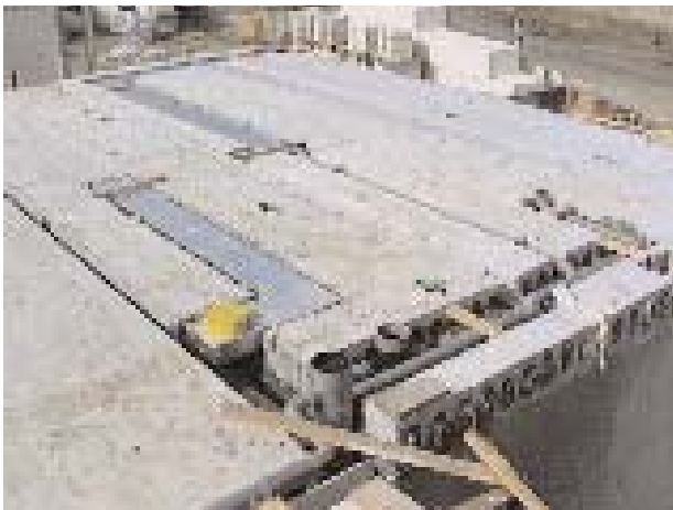
Gebalanceerde ventilatie in combinatie met riolering
