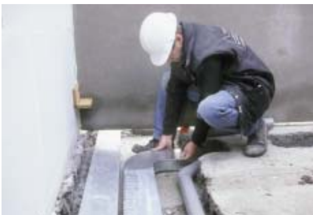
Monteren van de leidingen terwijl de woning al onder de kap is
