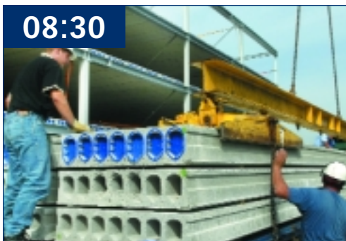
MONTAGE VAN DE TWAALF METER LANGE ELEMENTEN, VANAF DE VRACHTWAGEN
