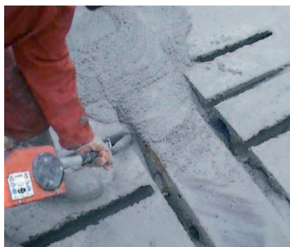
HET VULLEN VAN DE ALPHALIGGER GAAT GELIJKTIJDIG MET HET VULLEN VAN DE PLAATVOEGEN
