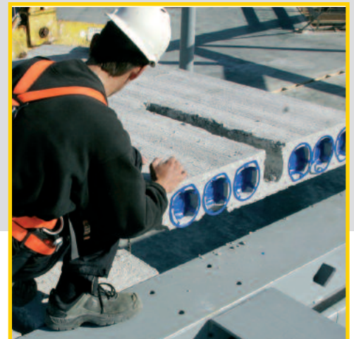
PLAATSEN VAN DE KANAALPLAAT OP DE FLENS VAN DE GEÏNTEGREERDE ALPHALIGGERS
