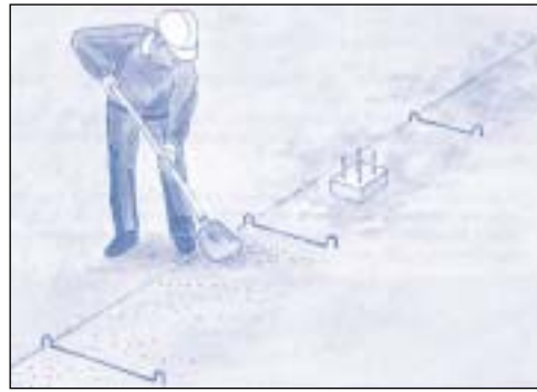
2. Egaliseer het zandbed op beugelhoogte
