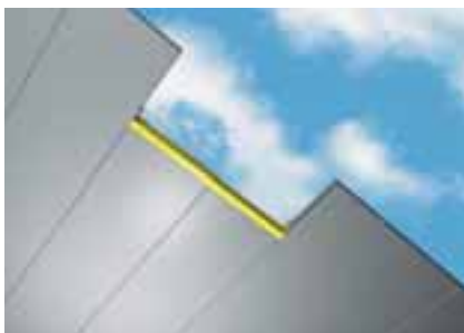
Oude situatie, raveelijzer in het zicht
